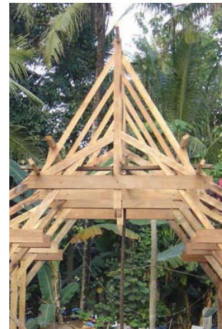
Indonésie ferme en bois système parasismique
