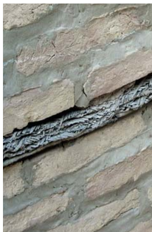
Ouzbekistan roseaux dans maçonnerie adobe système parasismique
