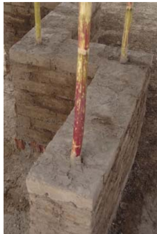
Pérou renforcement vertical système parasismique
