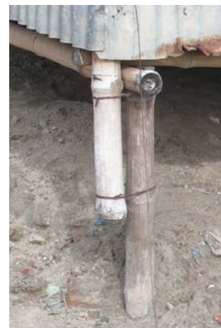
Bangladesh fixation poteau-pilotis changeable système parainondation
