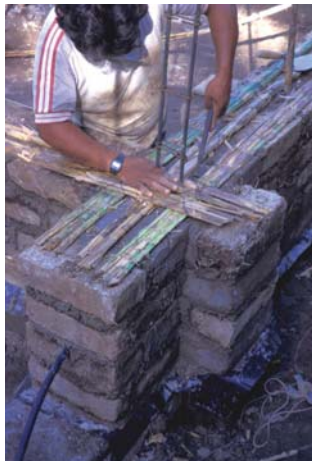
El Salvador renforcement horizontal système parasismique
