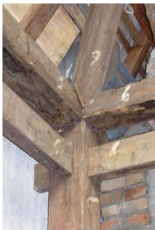
Indonésie connexion poteau-charpente système parasismique
