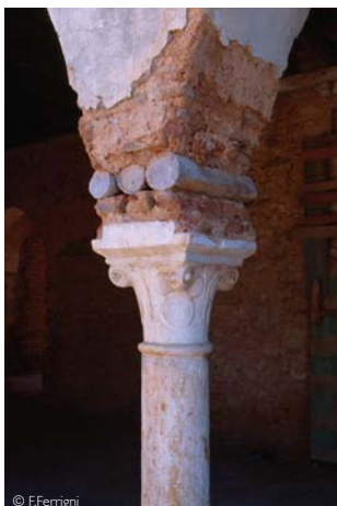
Algérie rondins de bois sur colonne système parasismique
