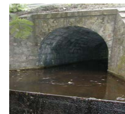
Ouvrage cadre à éviter : l'érosion a engendré l'impossibilité de franchir le cours d'eau
