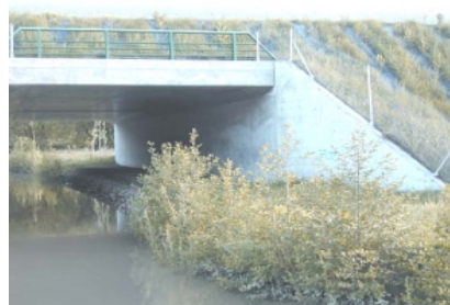
Exemple de passage mixte grande faune (berges reconstituées)
