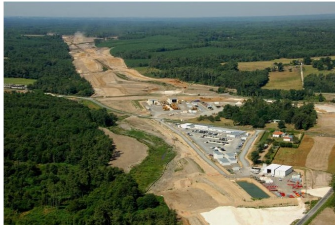
Chantier de la ligne à grande vitesse Tours-Bordeaux ( http://www.lgv-sea-tours-bordeaux.fr/ )
