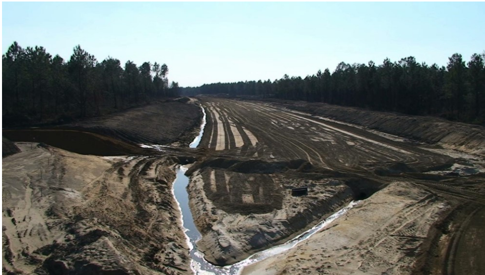
Chantier de l'autoroute A65 dans les Landes (40) en 2009
